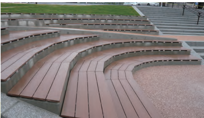
●階段デッキ(再生木材張り)
