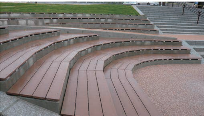
●階段デッキ(再生木材張り)
